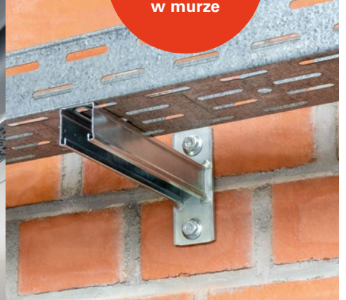
Montaż w murze
