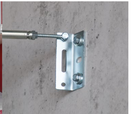
Montowanie wsporników i konsol
