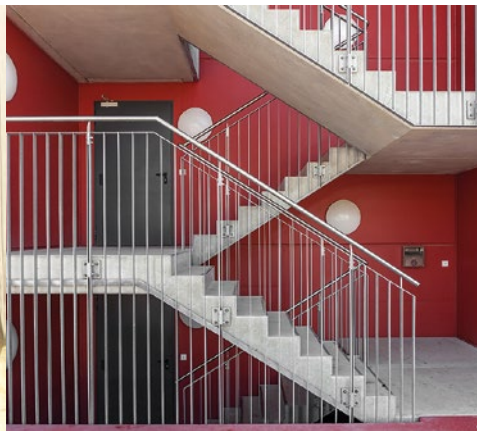
Montaż poręczy / balustrad
